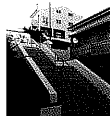
Praia da Tocha – Pintura de muros e guardas de segurança
