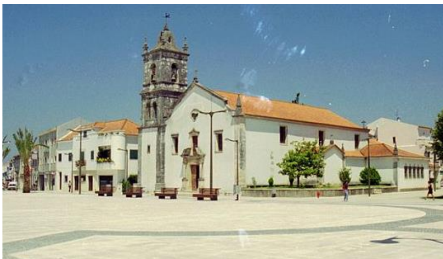
Figura 16. Igreja de São Pedro, matriz de Cantanhede: fachada poente (principal) e sul
