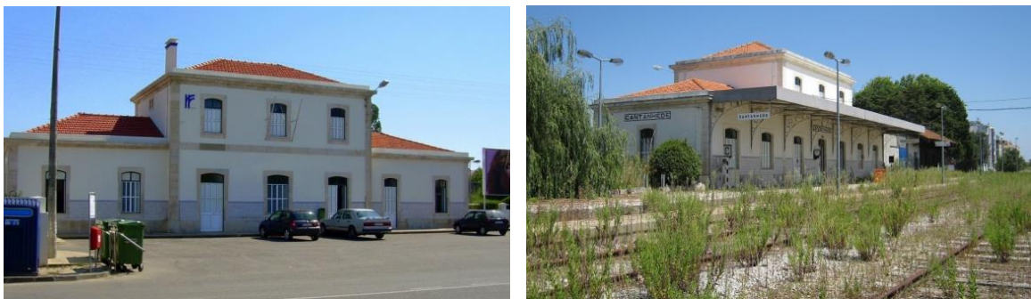
Figura 41 – Estação ferroviária de Cantanhede
