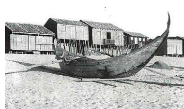
Figura 47. Palheiros de apoio à atividade piscatória
