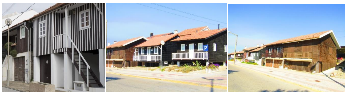
Figura 65. Construções recuperadas que mantém as características originais
