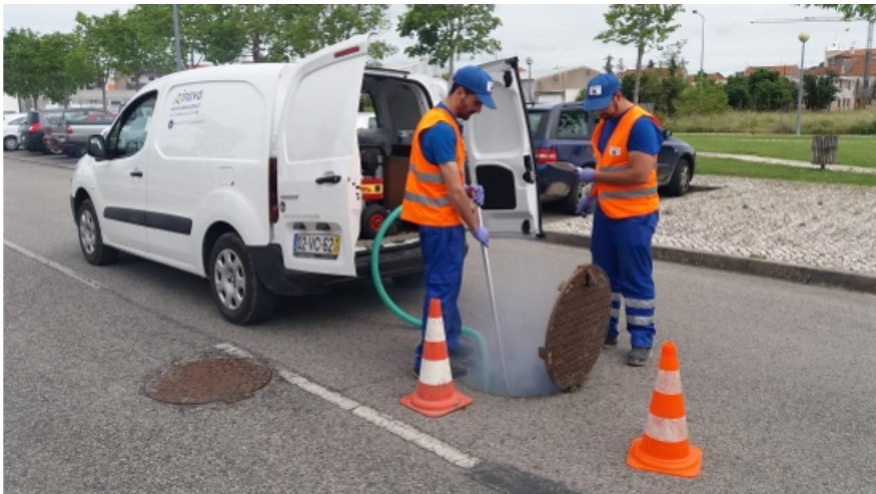
A INOVA-EM está a realizar, até ao próximo dia 17 de maio, ensaios na rede de drenagem de águas residuais de Sepins, de modo a aferir o estado de conservação e de funcionamento do sistema, com especial incidência na verificação da conformidade das ligações das redes prediais ao sistema público.
