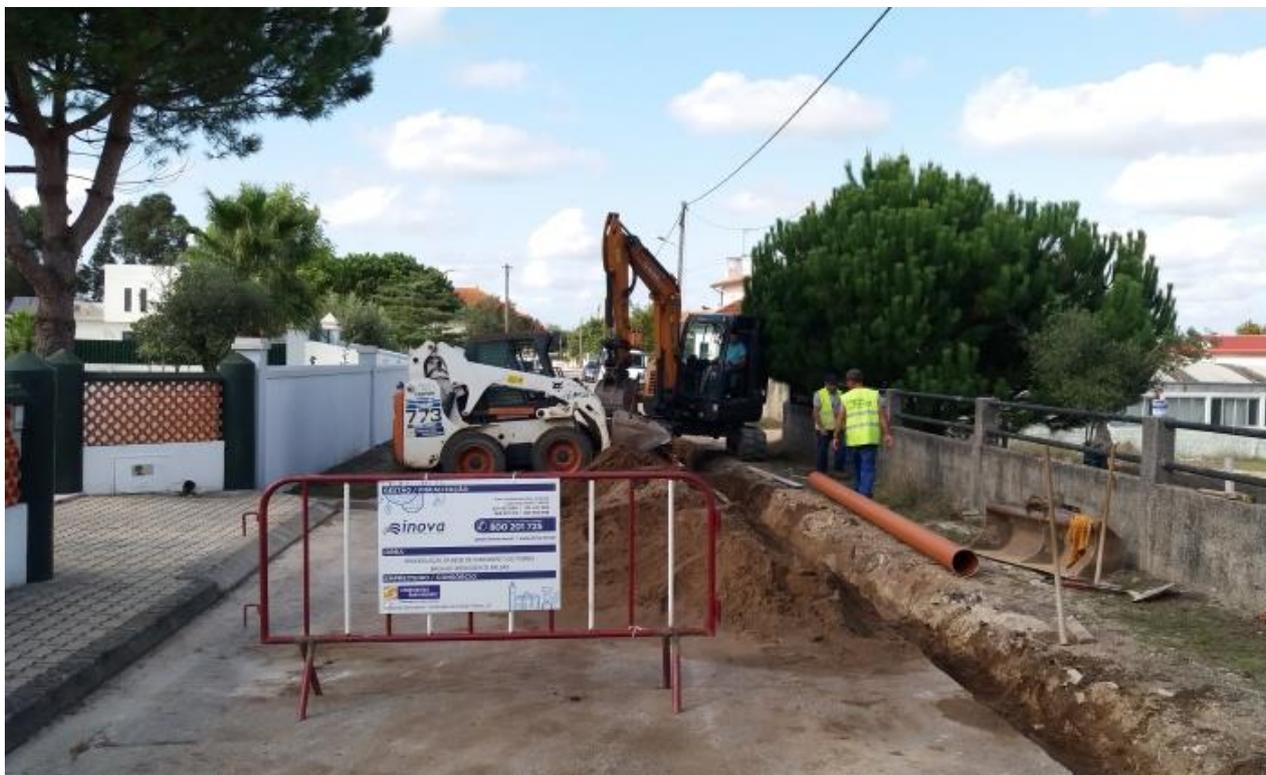
A INOVA prossegue com as obras de renovação do Sistema de Saneamento em Febres, mais concretamente na Bacia de drenagem da Estação Elevatória de Balsas, que conflui para o sistema da Águas do Centro Litoral.
